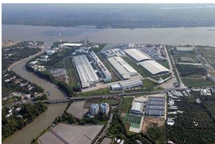
Một góc Khu công nghiệp Sông Hậu – Hậu Giang
